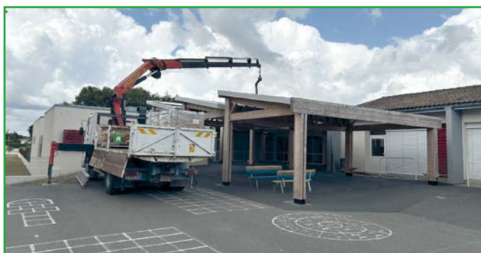
Mise en place des panneaux solaires
