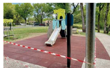
Pose du nouveau sol amortissant
