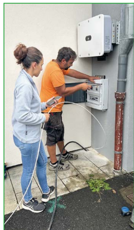
Installation de l'onduleur
