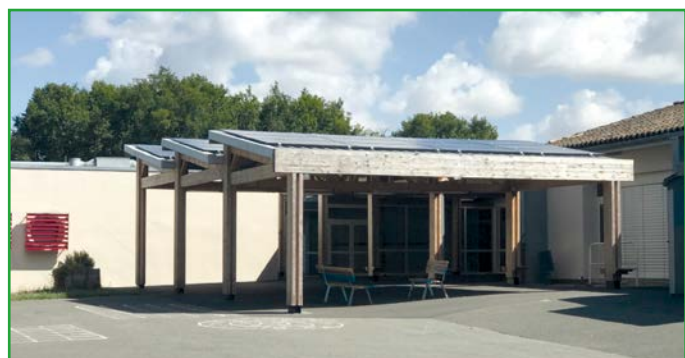
69 panneaux solaires de 500 Wc chacun sur 160 m 2 de toiture
